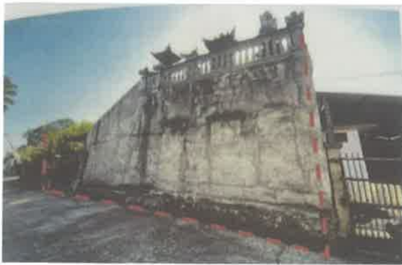
Tampak Depan Aset Kanan Jalan
